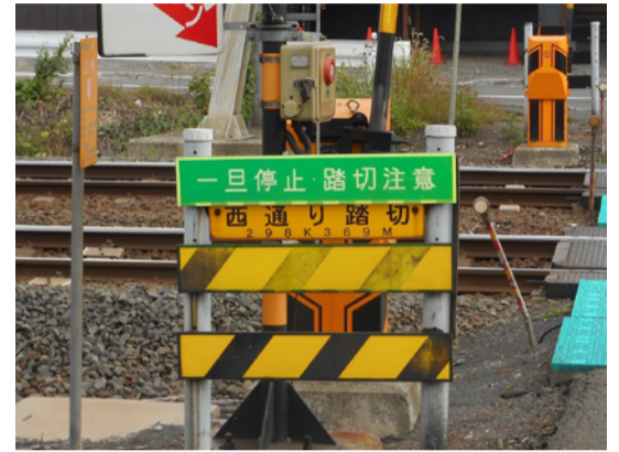
図2：JR函館本線「西通り踏切」
